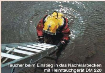
Taucher beim Einstieg in das Nachklärbecken mit Helmtauchergerät DM 220
