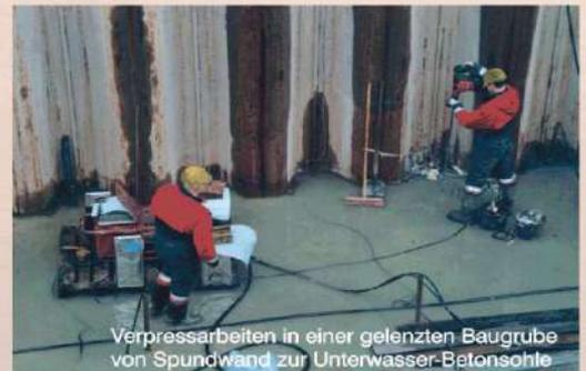
Verpressarbeiten in einer gelenzten Baugrube von Spundwand zur Unterwasser-Betonssole
