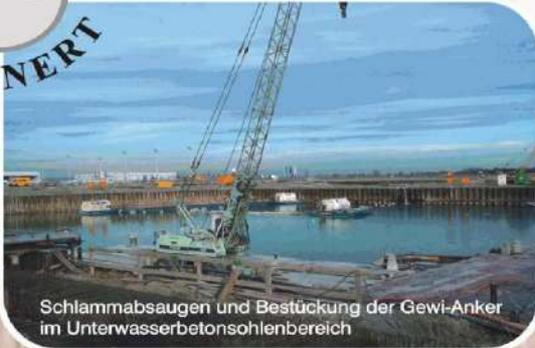
Schlammabsaugen und Bestückung der Gewi-Anker im Unterwasserbetonsohlenbereich
