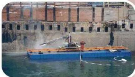
Hochdruckwasserstahlarbeiten an Schlitzwänden
