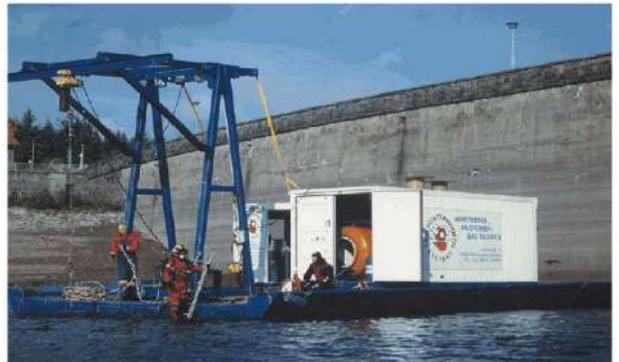
Hier zu sehen: Pontoneinheit, Tauchcontainer/ Mischgascontainer mit Taucherdruckbehandlungskammer, A-Mast mit elektrischem Kettenzug (Traglast bis 3,5 t) für Arbeiten in unterschiedlichen Wassertiefen Baustelle bei Arle an Trinkwasserentnahmestellen
