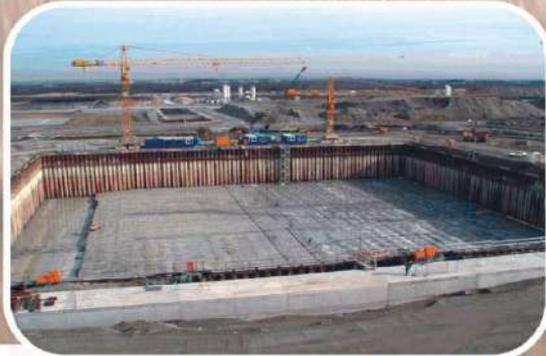
Baugrube nach Betonage im gelenzten Zustand mit Vertiefung der Sohle für den S-Bahn - Tunnel. Betonieren einer ca. 20 m langen Schräge die danach horizontal ausläuft
